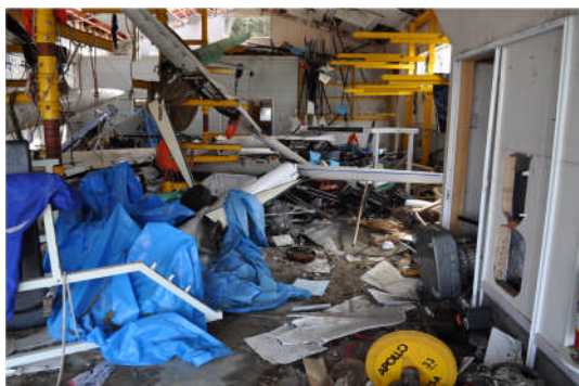
震災直後のボート部艇庫
